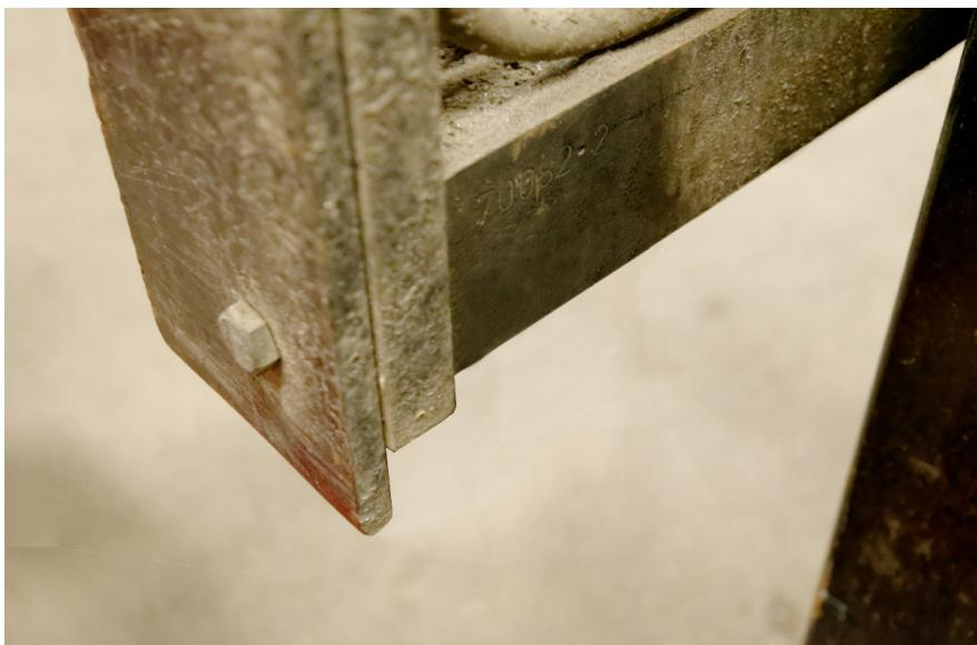
2. Tenez le support avec l'aimant supérieur redressé et montez le support sur le bord inférieur de la poutre en acier. Les deux aimants dans le bord supérieur et avant du support guideront le support contre la poutre en acier - vérifiez que le support est complètement en bord avec la poutre en acier. L'accessoire est maintenu en place même en cas de fortes vibrations et chocs.
